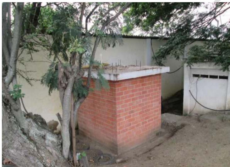
Vista 29 de mayo de 2019 - Caseta construida encima del pozo profundo
