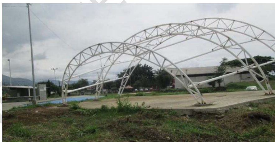
Vista 29 de mayo de 2019 - Estructura y piso construido para instalación de cubierta en tarima
